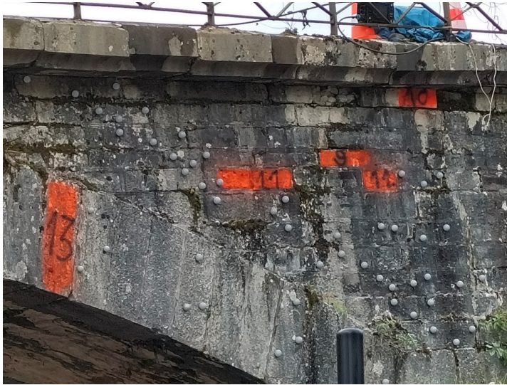
Cibles sur le pont d'Osserain.
